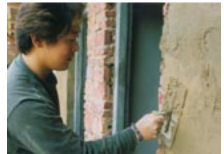
棟梁は真人が大好き。難しい壁塗りも真人にまかせる
